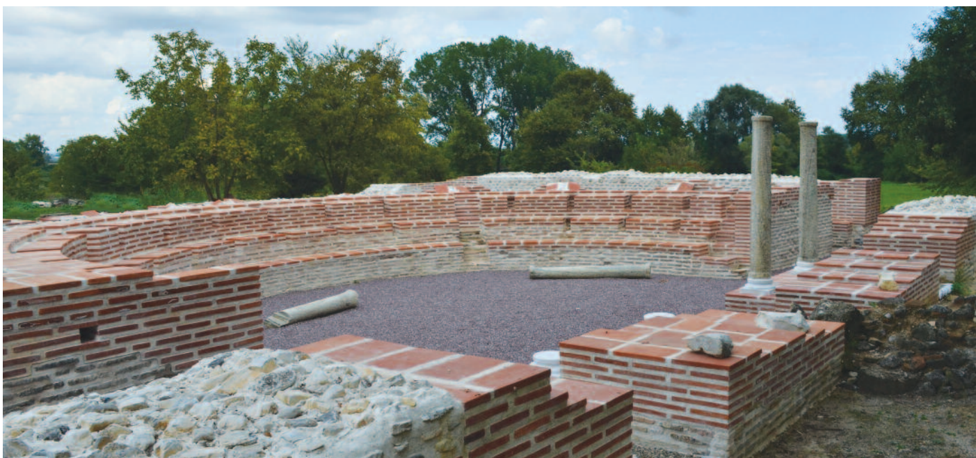
Εικ. 91. Η τελική εικόνα μετά τις εργασίες αποκατάστασης του μνημείου.
