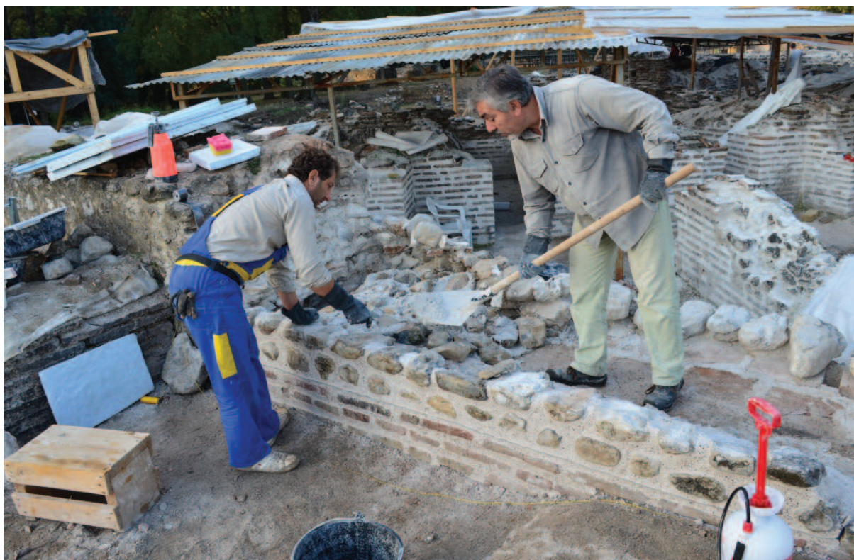
Εικ. 59. Ανάκτηση της λιθοδομής του ανατολικού περιμετρικού τοίχου.
