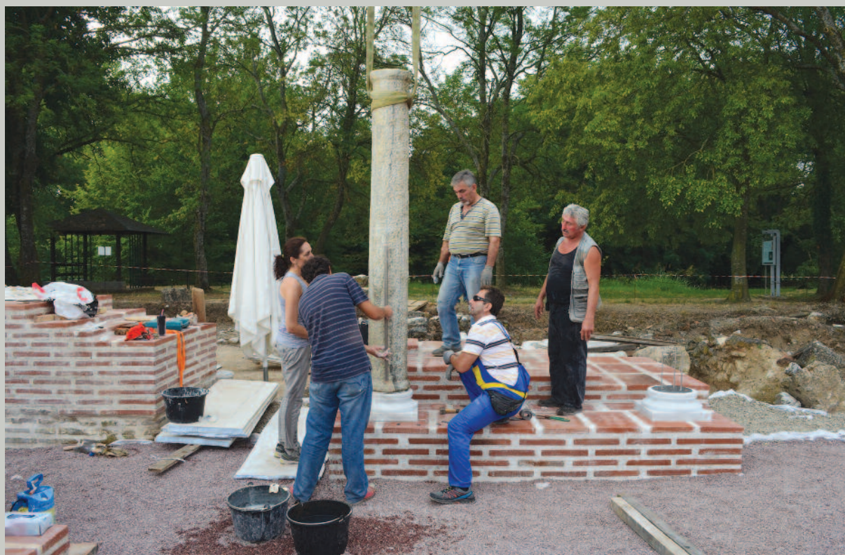
Εικ. 85. Η ευθυγράμμιση του κίονα μετά την τοποθέτησή του.
