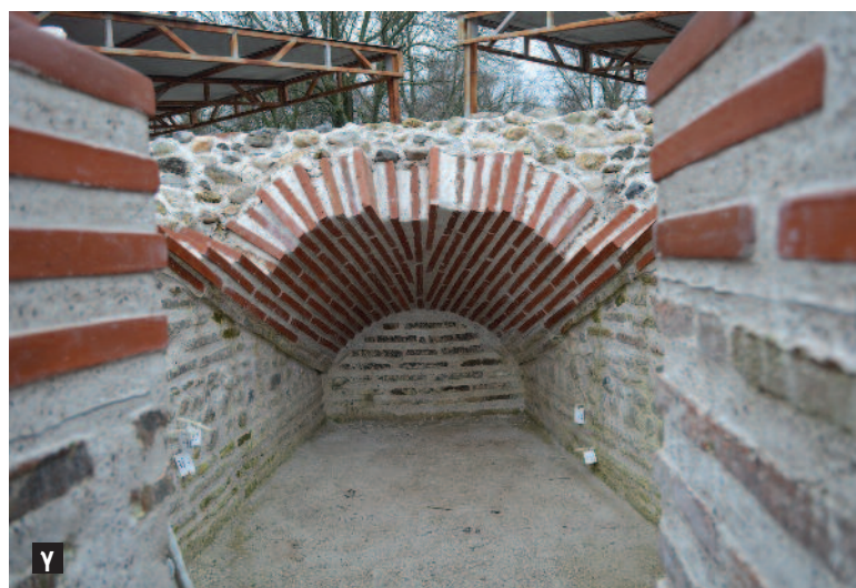
Εικ. 62α,β,γ. Το σύστημα στήριξης, η κατασκευή του ξυλότυπου και η τελική εικόνα της σφηνοειδούς καμάρας.
