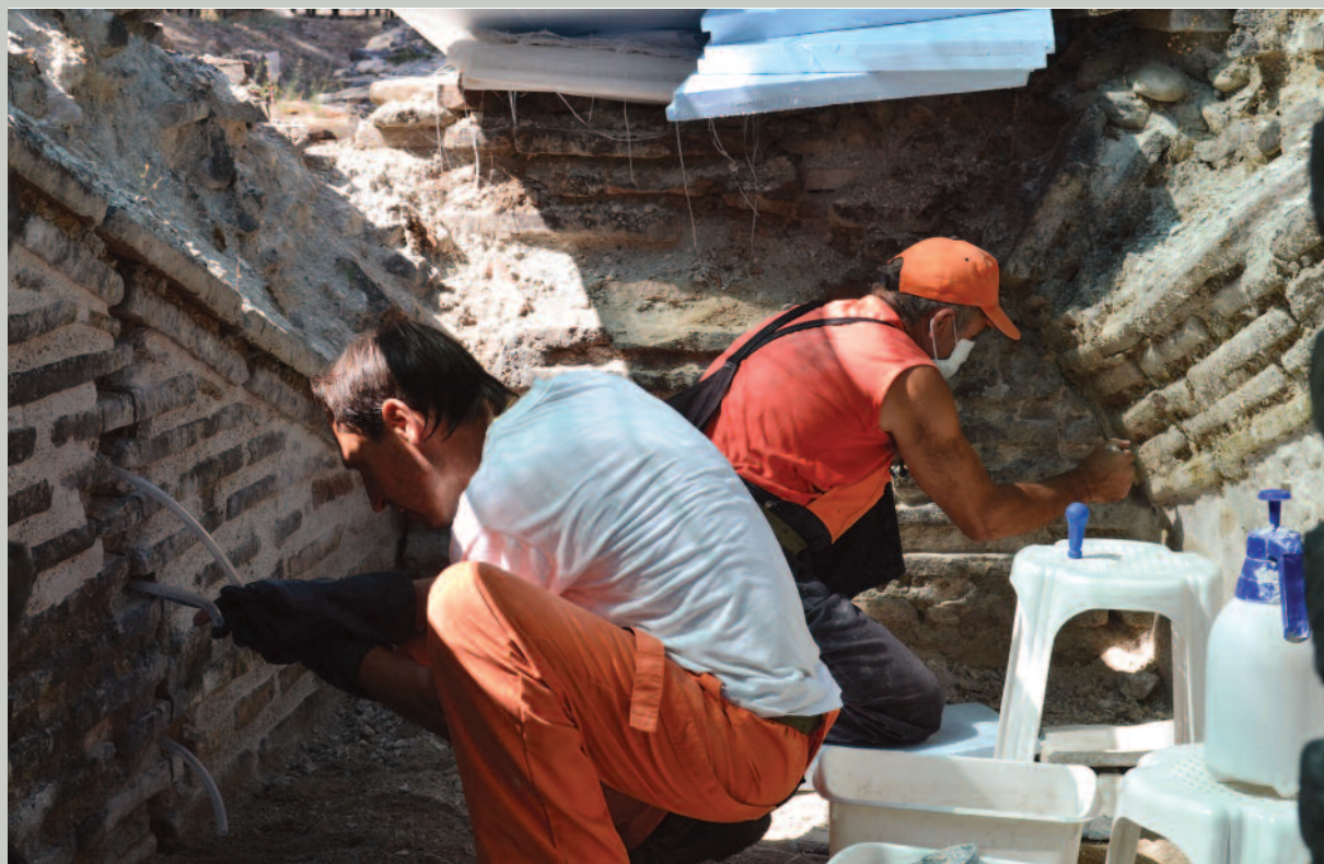
Εικ. 66. Τοποθέτηση σωληνίσκων για την εισαγωγή ενέσιμου υλικού.
