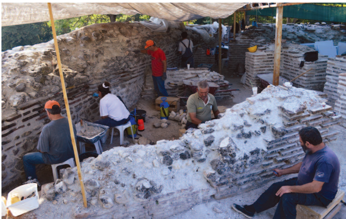
Εικ. 54. Εργασίες καθαρισμού και αρμολόγησης στην ανατολική πλευρά του μνημείου.
