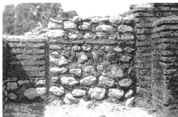
Εικ. 37. Το ωδείο των θερμών του Δίου. Κλείσιμο του ανοίγματος της δυτικής θύρας με αργολιθοδομή.
