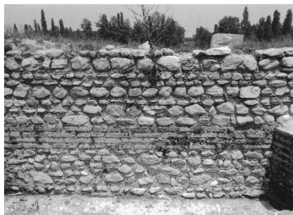
Εικ. 33. Το ωδείο των θερμών του Δίου. Τοιχοποιία σε opus mixtum.
