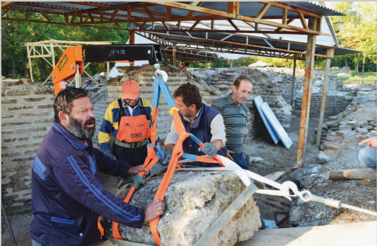
Εικ. 86. Ανύψωση γωνιόλιθου.
