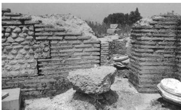
Εικ. 35. Το ωδείο των θερμών του Δίου. Η βορειοδυτική, μεγάλη γωνιακή αντηρίδα σε "opus maxtum".
