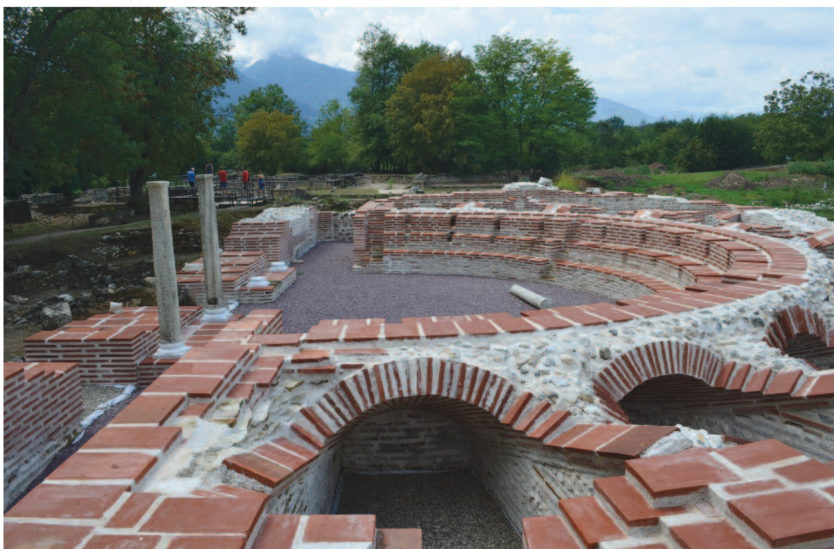
Εικ. 90. Η τελική εικόνα του Ωδείου, μετά την ολοκλήρωση των εργασιών.
