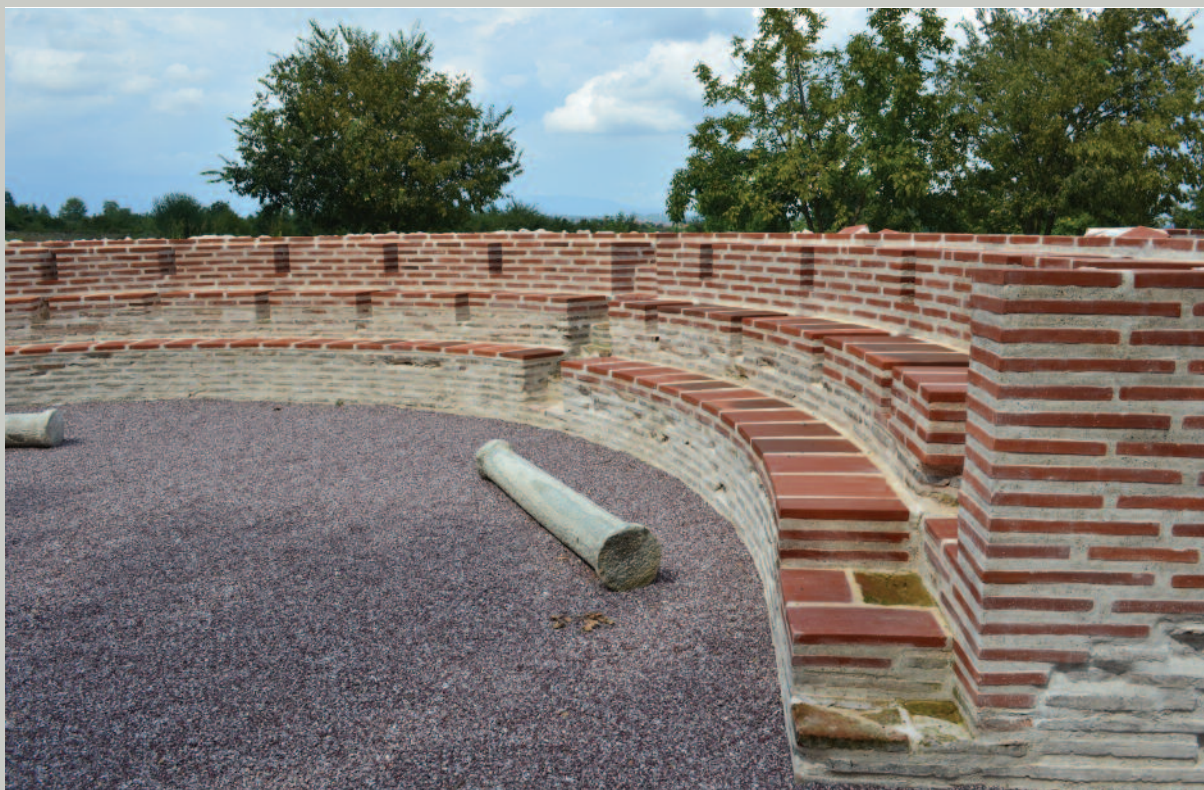
Εικ. 64. Η εικόνα του κοίλου μετά τις εργασίες αποκατάστασης.
