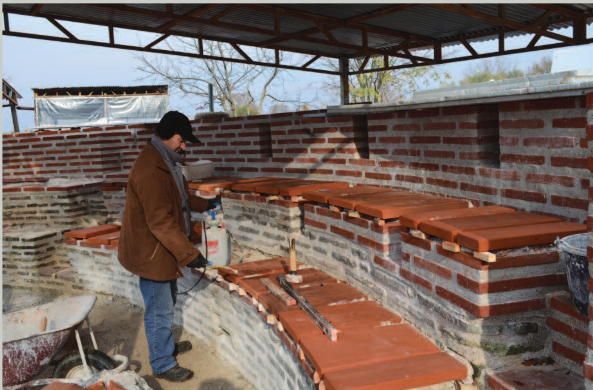
Εικ. 63. Εργασίες ανάκτησης της τελευταίας σειράς πλίνθων του κοίλου.
