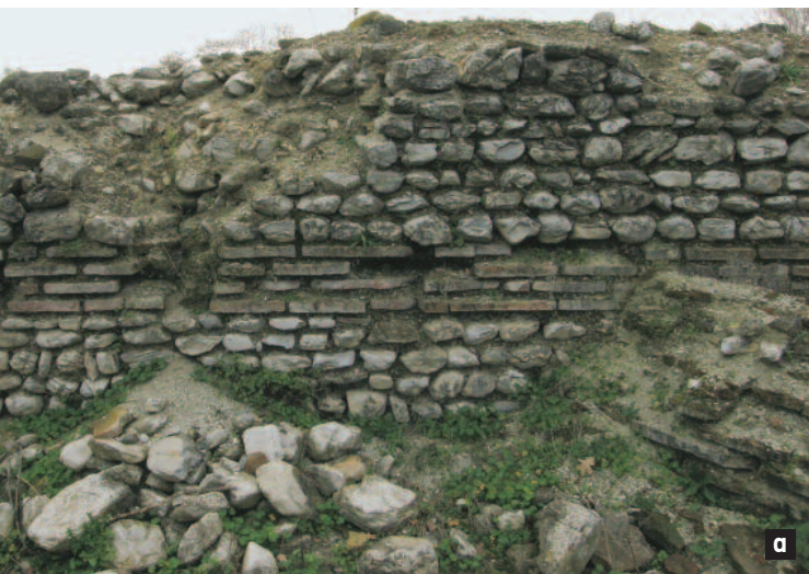
Εικ. 56 α,β. Κατάρρευση τμήματος της εσωτερικής παρειάς του ανατολικού τοίχου, πριν και μετά τις εργασίες ανάκτησης.
