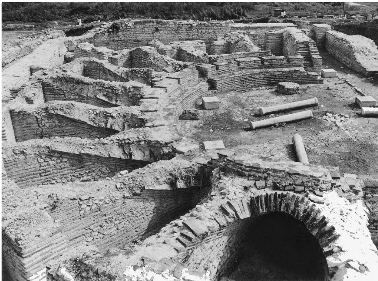
Εικ. 28. Μερική άποψη του ωδείου. Διακρίνονται οι δυο δακτύλιοι, οι ακτινωτοί τοίχοι του κοίλου, οι σφηνοειδείς καμάρες και η στήριξη των βαθμίδων των καθισμάτων επάνω σε αυτές.
