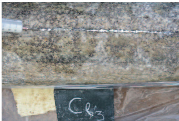
Εικ. 81. Ενίσχυση ρήγματος με εισαγωγή λευκού τσιμέντου.
