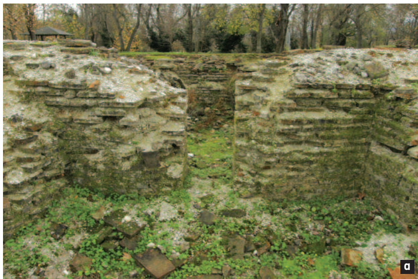
Εικ. 57 α,β,γ. Παραστάδες πριν, κατά τη διάρκεια, και μετά τις εργασίες αποκατάστασης.
