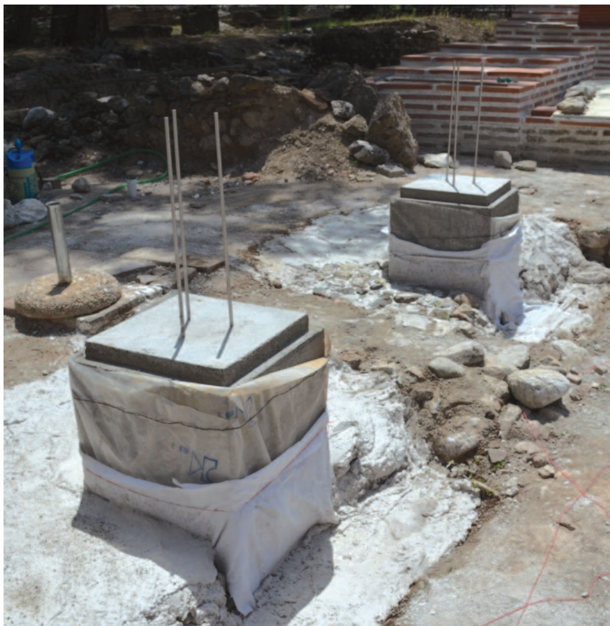
Εικ. 83. Τα θεμέλια από οπλισμένο σκυρόδεμα στον χώρο του ανατολικού ποδίου του προσκηνίου.
