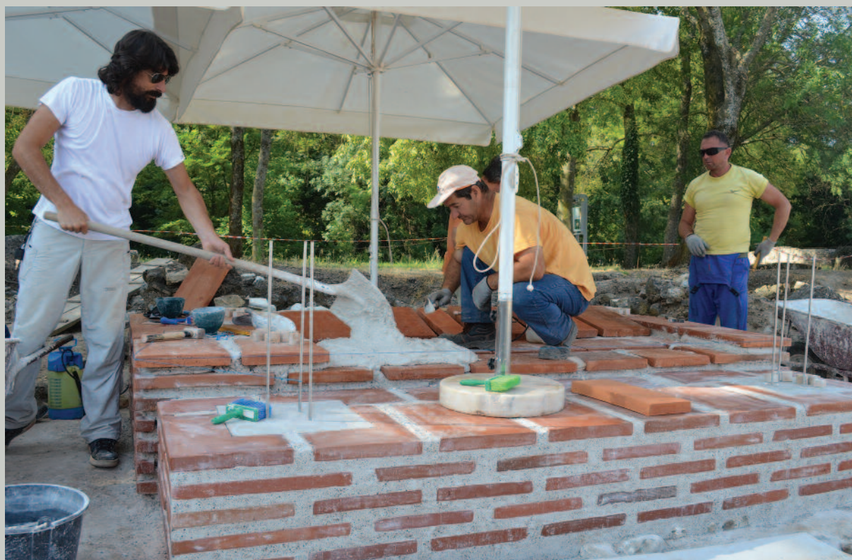
Εικ. 84. Εργασίες ανάκτησης του ανατολικού ποδίου και του νότιου τοίχου.
