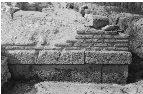
Εικ. 34. Το ωδείο των θερμών του Δίου. Ενίσχυση της βορειοανατολικής γωνίας του εξωτερικού τοίχου με μεγάλους γωνιόλιθους χαμηλά και με πλινθοδομή (opus testaceum) ψηλότερα.
