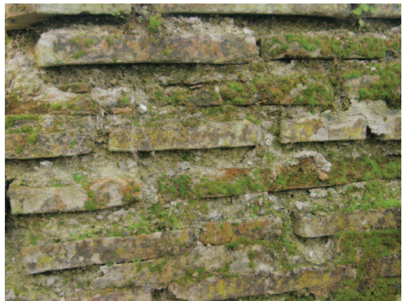
Εικ. 48. Βιολογικοί σχηματισμοί στην επιφάνεια πλινθοδομής.
