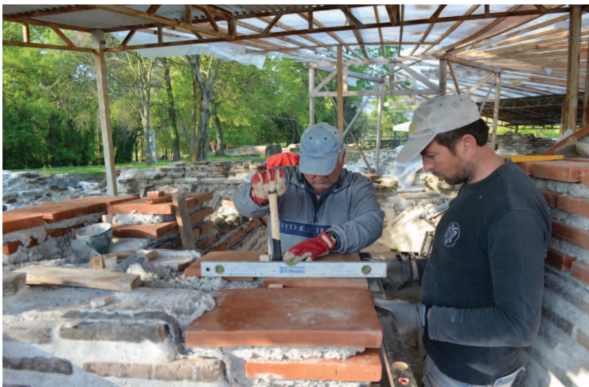
Εικ. 58. Ανάκτηση πλινθοδομής.
