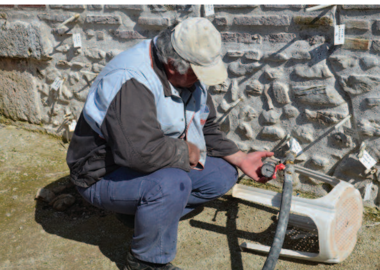
Εικ. 68. Έλεγχος της πίεσης κατά τη διαδικασία εφαρμογής των ενεμάτων.
