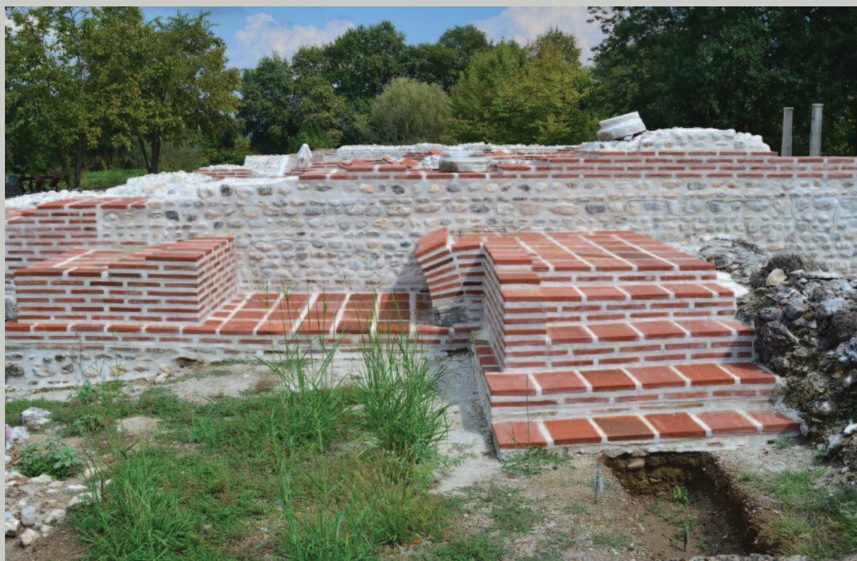
Εικ. 65. Η δυτική εξωτερική κλίμακα μετά τις εργασίες αποκατάστασης.
