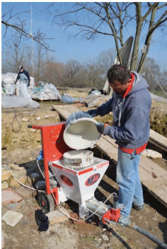
Εικ. 67. Μεταφορά του υλικού στο μηχανήμα άντλησης και προώθησης ενεμάτων.
