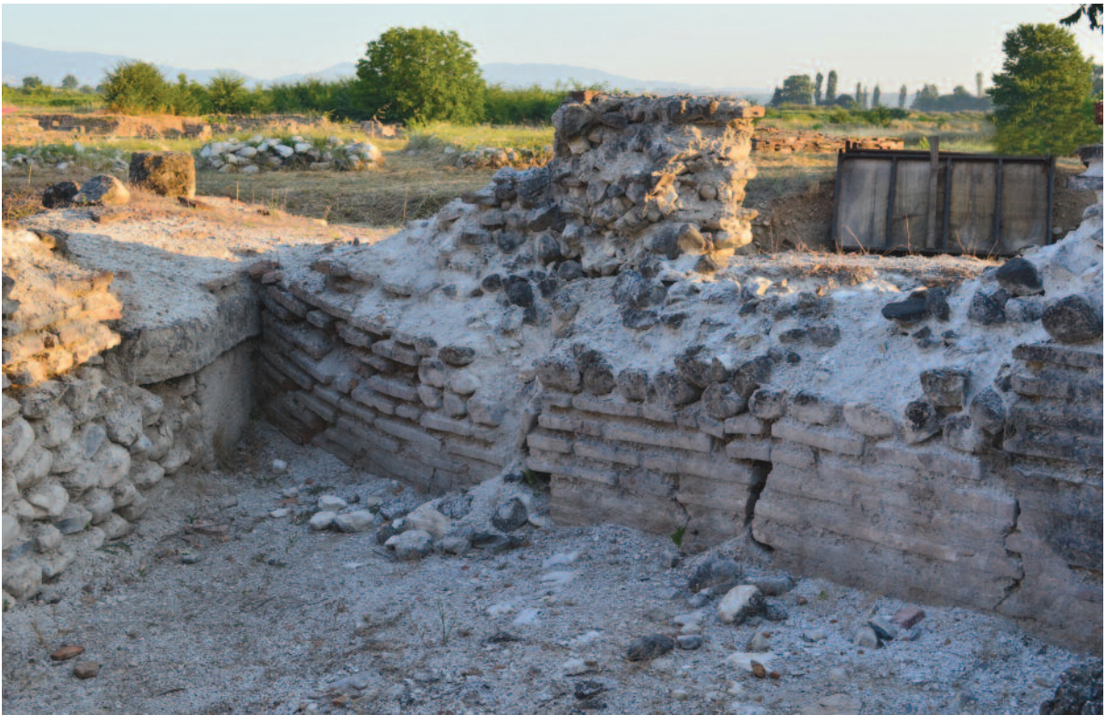
Εικ. 46. Βύθση του μνημείου και δημιουργία ρηγμάτων.
