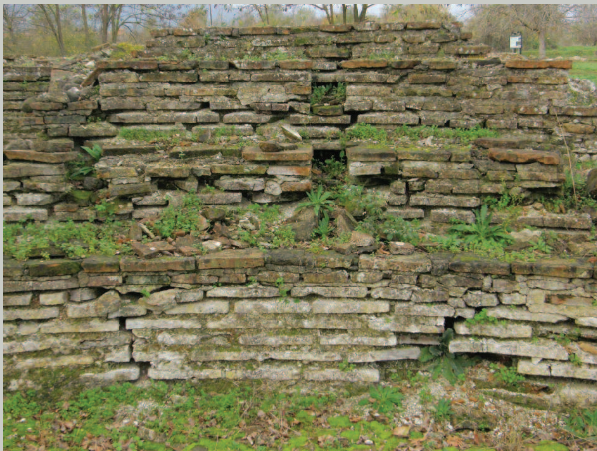
Εικ. 51. Επεμβάσεις με τσιμεντοκονίαμα στις βαθμίδες του κοίλου.
