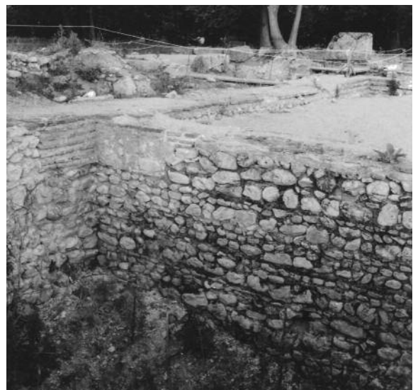
Εικ. 30. Ο τοίχος θεμελίωσης του συγκροτήματος των θερμών, ο οποίος προχωρεί σε βάθος 4 μέτρων.
