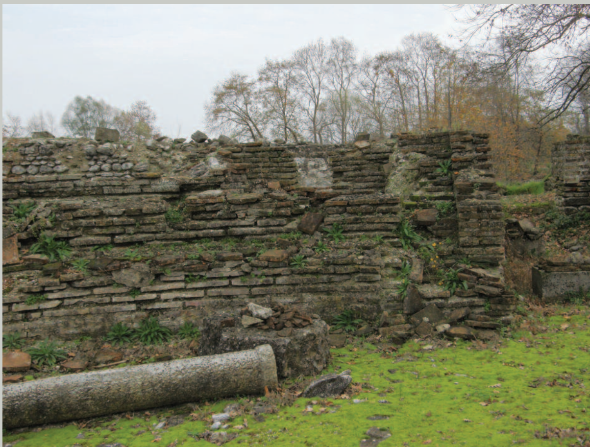
Εικ. 49. Ανάπτυξη ανώτερης βλάστησης στον χώρο του κούλου.
