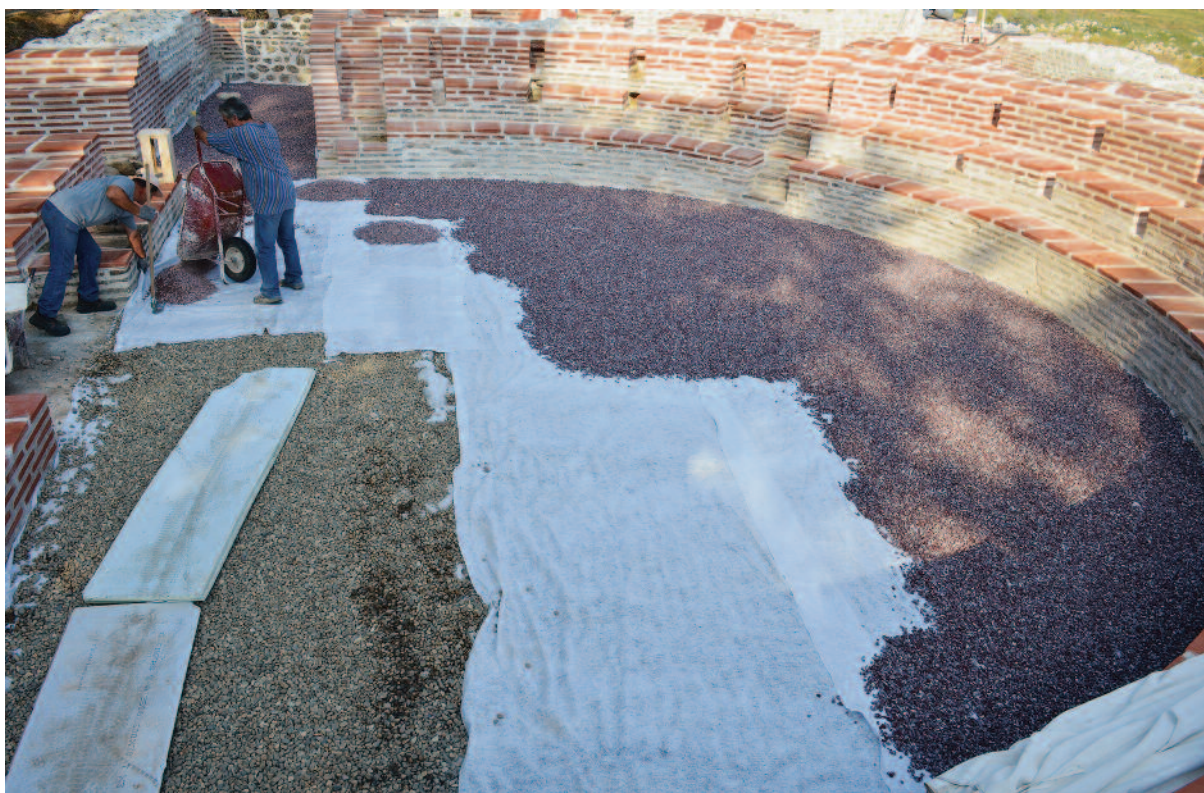
Εικ. 89. Επίστρωση του δαπέδου της ορχήστρας.
