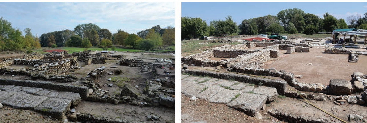
Εικ. 2 Η «Οικία Επιγένου» πριν και μετά τις εργασίες στερέωσης και ενίσχυσης των τοιχοδομών (Εφορεία Αρχαιοτήτων Πιερίας).
