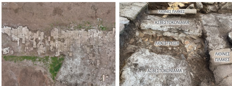
Εικ. 5 Η πλακόστρωση της πλατείας και η κατασκευή της υποδομής της (Εφορεία Αρχαιοτήτων Πιερίας. Επεξεργασία εικόνας: Σ. Κουλίδου).
