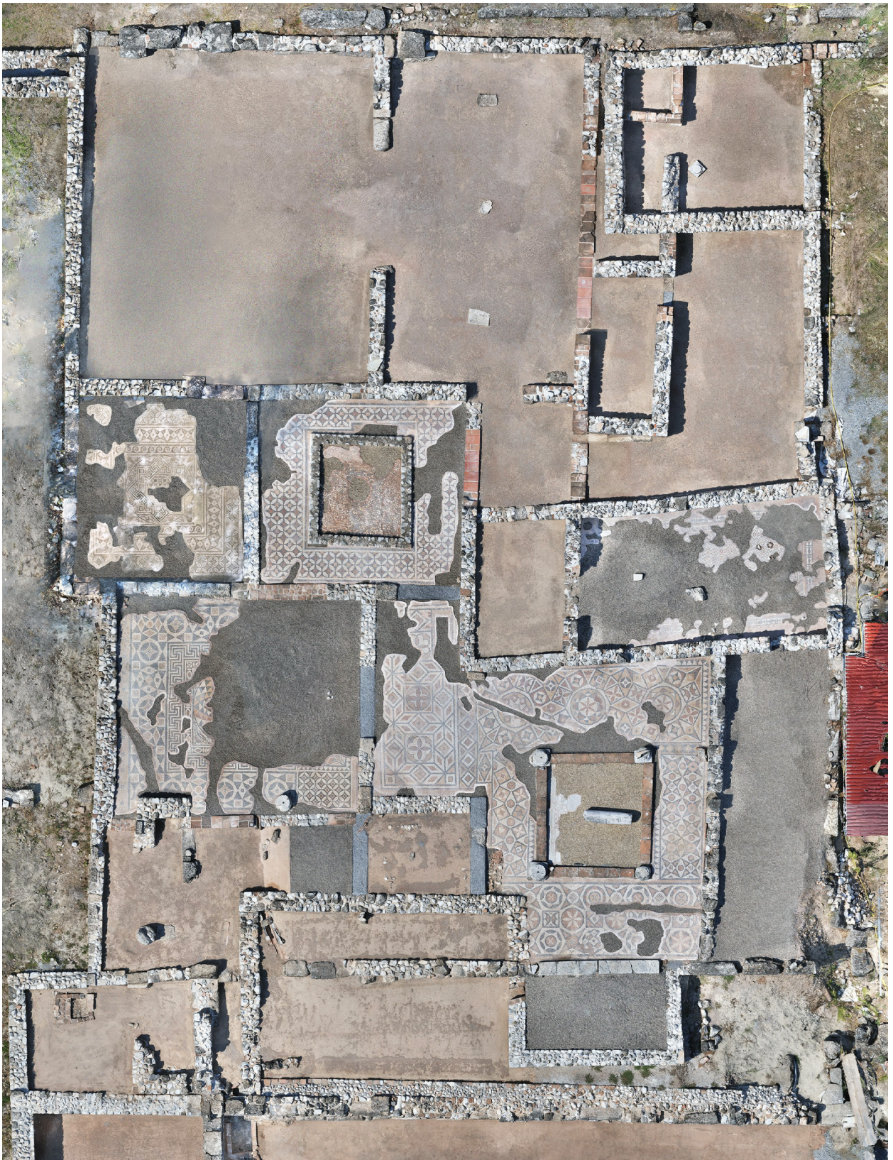
Η «Οικία Επιγένους», μετά την αποπεράτωση των εργασιών αποκατάστασης, συντήρησης και ανάδειξης.
