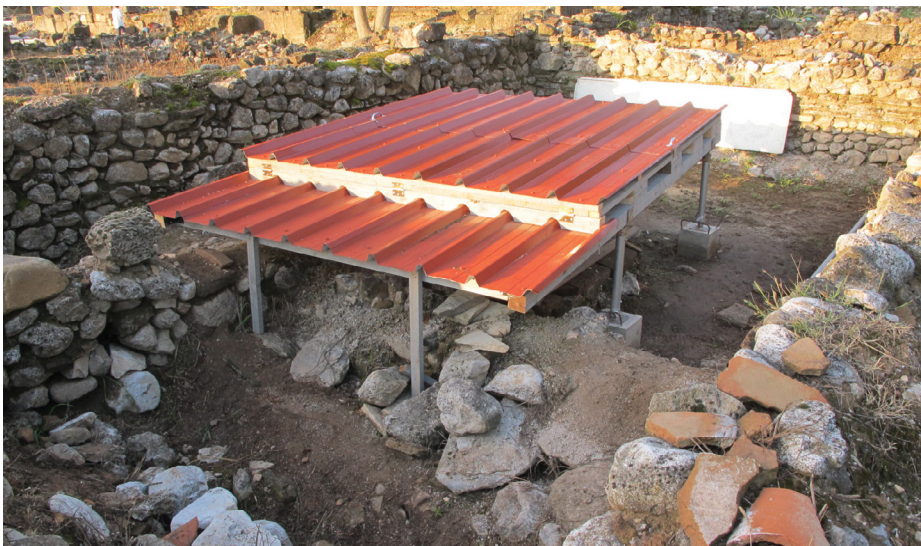
Στέγαστρο προστασίας στην είσοδο της υπόγειας αποθήκης.
