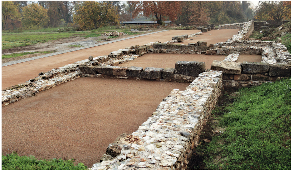
Νότιο κτήριο της αγοράς. Το ανατολικό τμήμα του κτηρίου και η κεντρική αίθουσα μετά τις εργασίες αποκατάστασης
