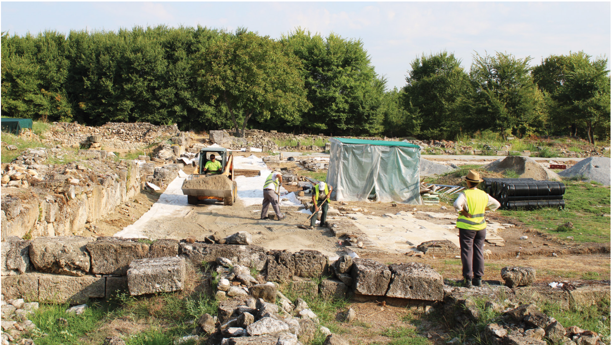
Εργασίες διαστρώσεων αδρανών υλικών στη δυτική στοά της αγοράς.
