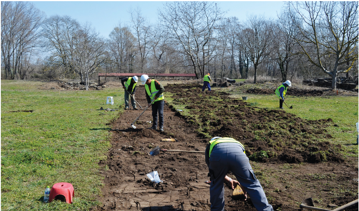
Πλατεία αγοράς. Εργασίες αποχωμάτωσης.
