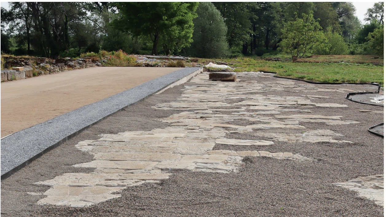
Πλάκες αγοράς και βόρεια στοά, μετά την ολοκλήρωση των εργασιών συντήρησης, αποκατάστασης και διάστρωσης.
