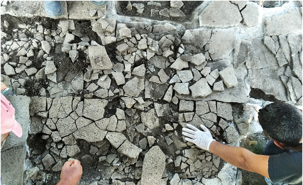
Πλατεία αγοράς. Εργασίες συντήρησης των λίθινων πλακών.
