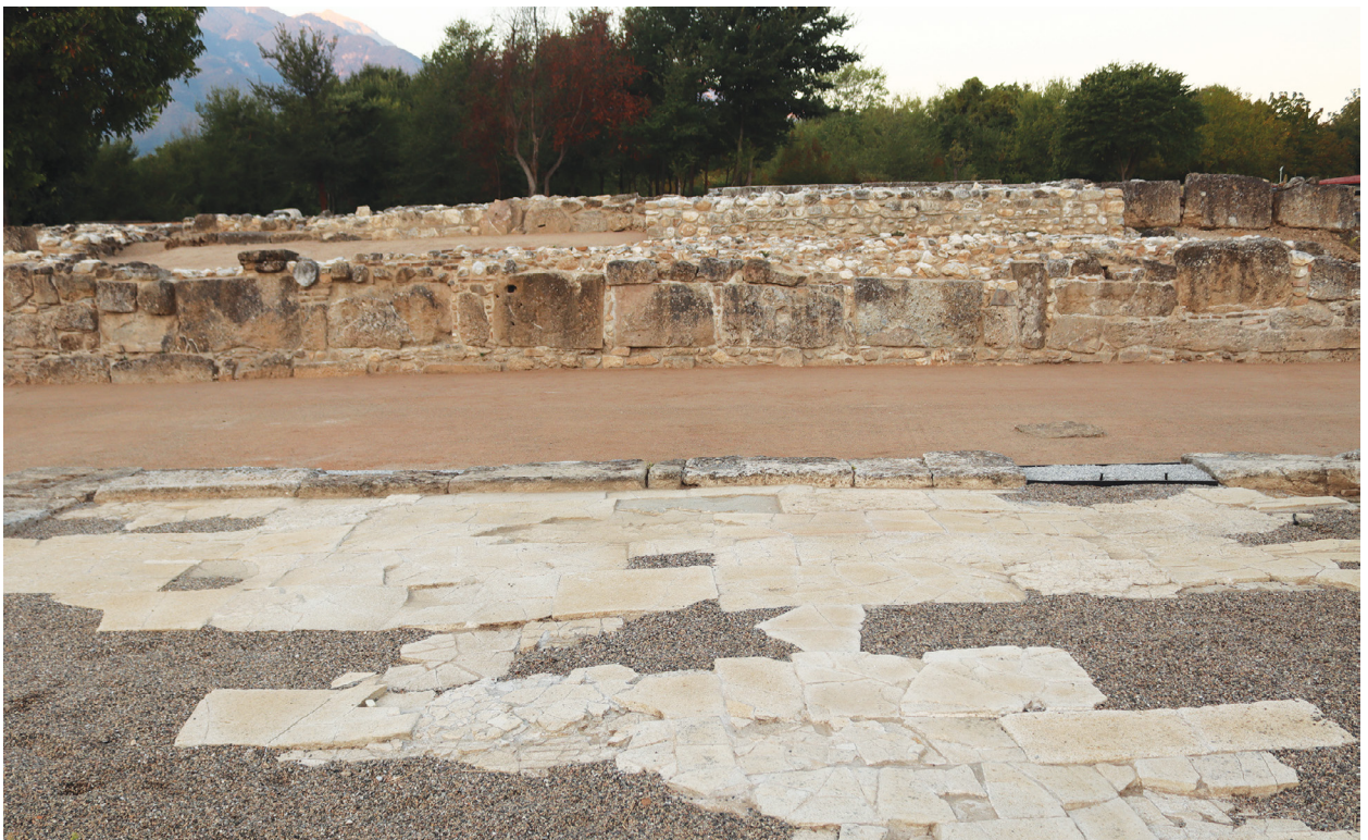
Πλατεία αγοράς. Το νότιο σωζόμενο τμήμα των λίθινων πλακών μετά τις εργασίες συντήρησης.
