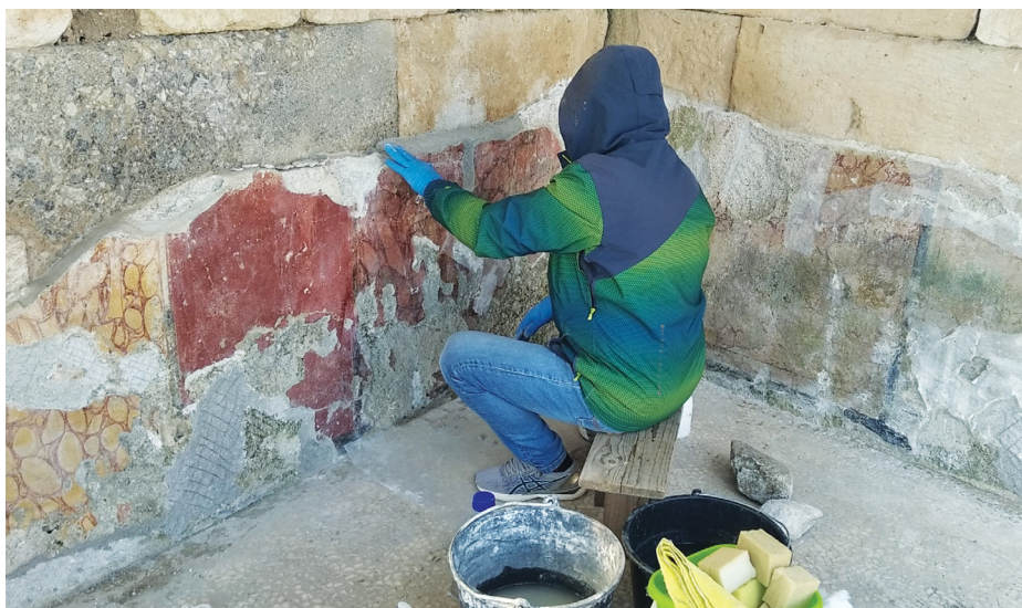
«Σεβαστείο». Εργασίες συντήρησης του νότιου τμήματος της τοιχογραφίας.
