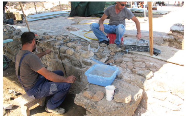
«Οικία Επιγένους». Εργασίες ανάκτησης τοιχοδομής.
