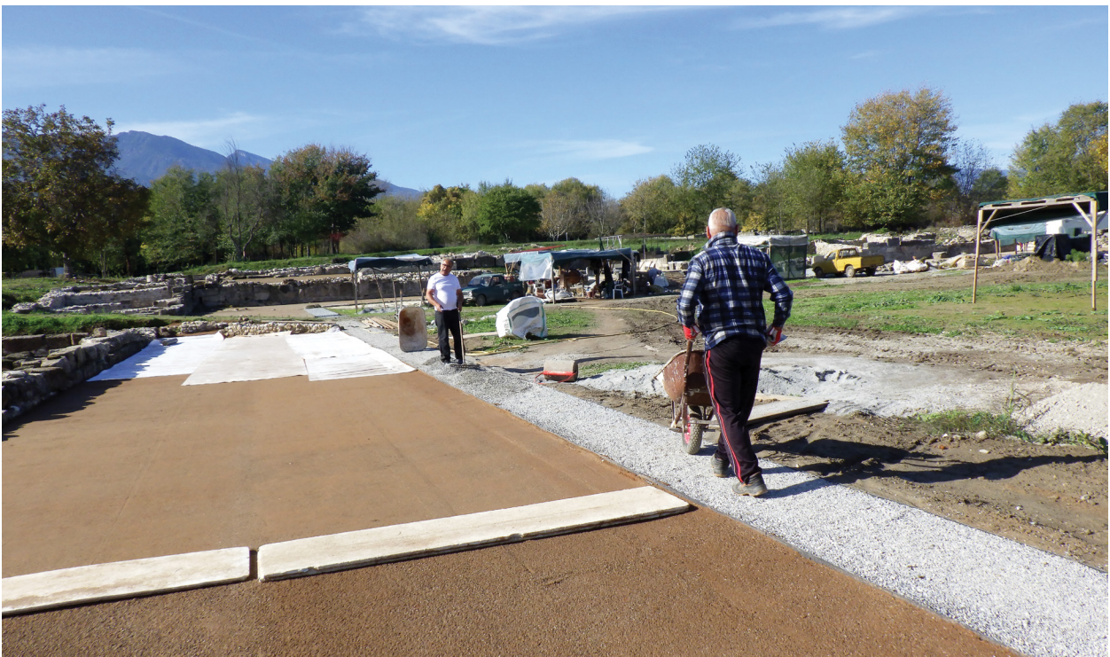
Νότιος στυλοβάτης. Πλήρωση των κυψελωτών πλαισίων με αδρανή υλικά.
