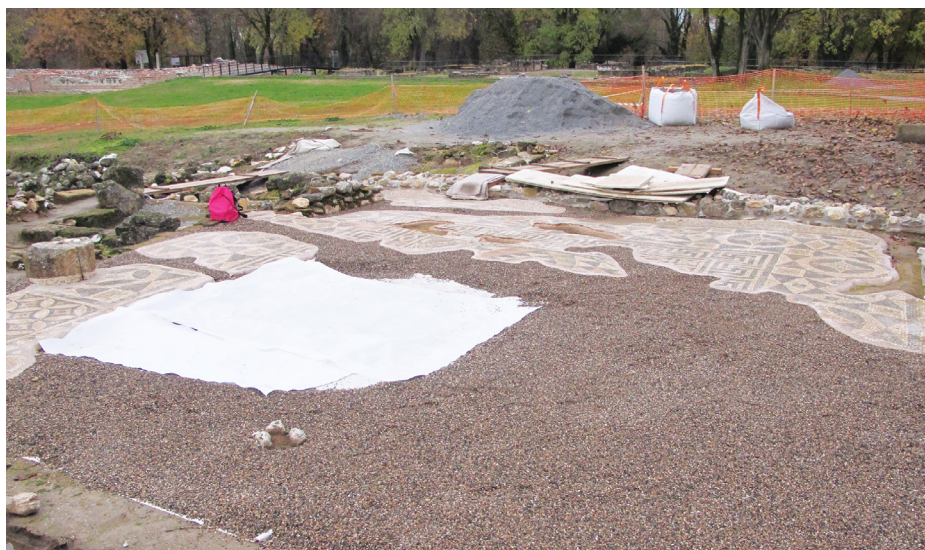
«Οικία Επιγένους». Τελική επίστρωση χρωματιστού χαλικιού στα τμήματα της επιφάνειας που δεν διατηρούνται ψηφιδωτά δάπεδα.
