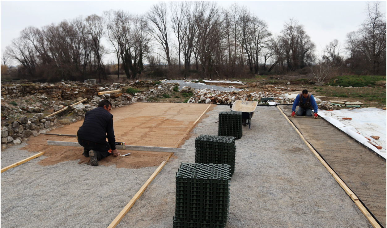
Εφαρμογή σταθεροποιημένου χωμάτινου δαπέδου στη βόρεια στοά και διάστρωση στυλοβάτη.
