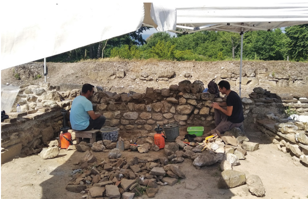
«Οικία Επιγένους». Εργασίες εφαρμογής κονιαμάτων στους αρμούς των τοιχοποιιών.
