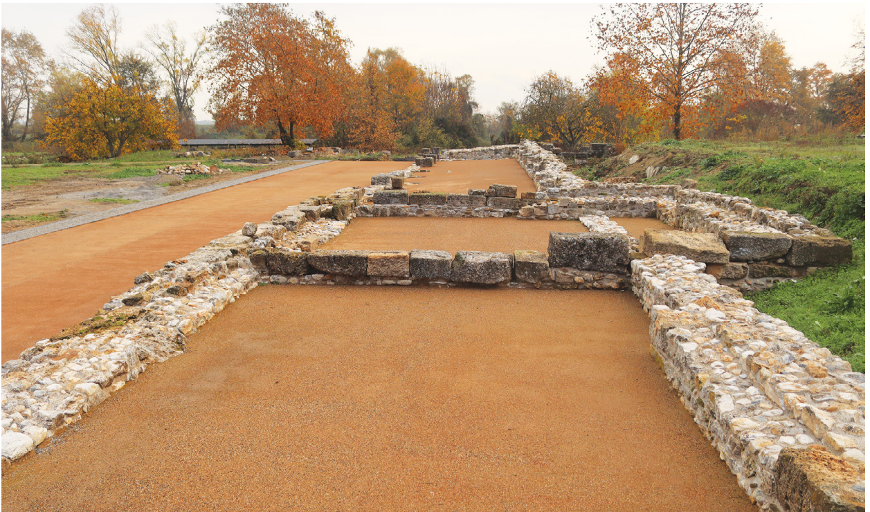
Το νότιο κτήριο της αγοράς και η στοά, μετά την αποπεράτωση των εργασιών αποκατάστασης και ανάδειξης.
