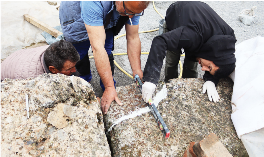
Συγκόλληση τμημάτων λιθοπλίνθου στον βόρειο τοίχο του νότιου τμήματος.
