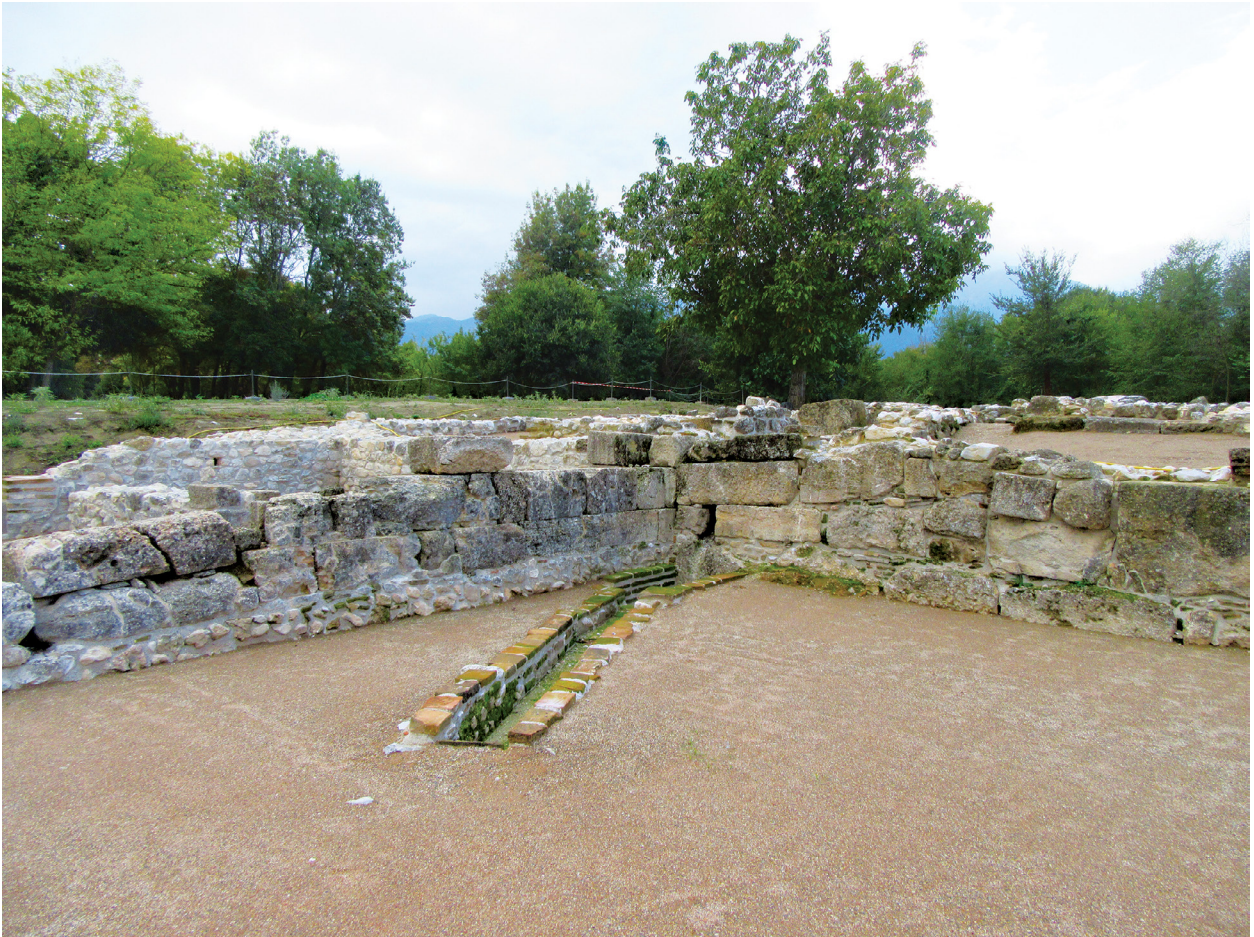
Φρεάτιο και αποχετευτικός αγωγός στη ΝΔ γωνία της αγοράς, μετά την ολοκλήρωση των εργασιών συντήρησης και αποκατάστασης.
